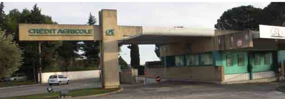
Centre régional du Crédit Agricole à Nîmes. Bâtiment d'accueil doté d'un spectaculaire porte-à-faux.
